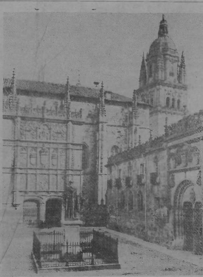
Rincones de la Patria: Fachada principal de la Universidad de Salamanca
