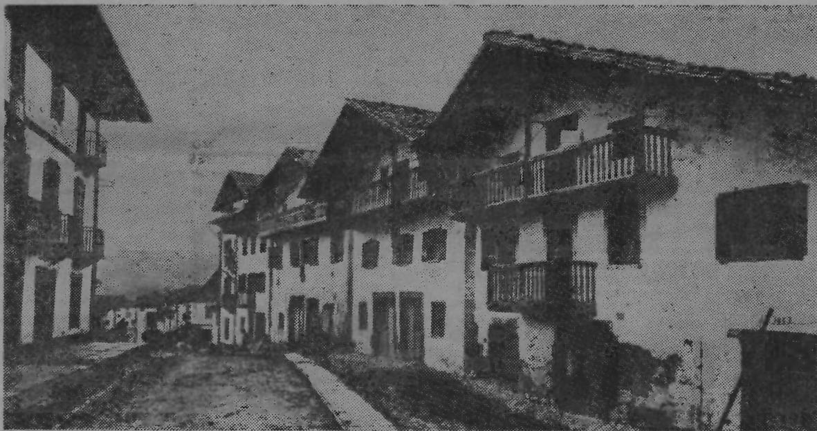
Casas del Baztán (Navarra)
