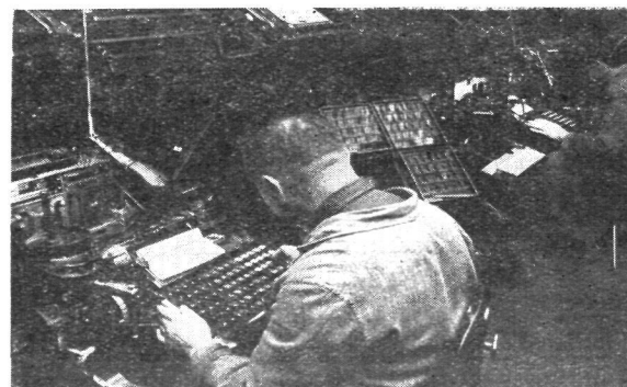
Z maszyny linotypowej wychodzą w miarę składania gorące sztabki z gotowymi linijkami tekstu
