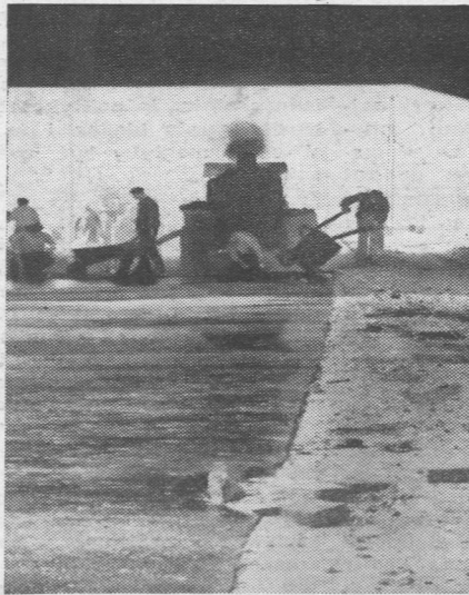
Asfaltowanie jezdni pod wiaduktem żoliborskim na ulicy Nowotki.
