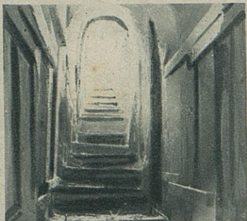
LE COULOIR sur lequel donne l'entrée du poste du document de gauche. On remarque à gauche et à droite l'entrée béante de divers autres postes.
