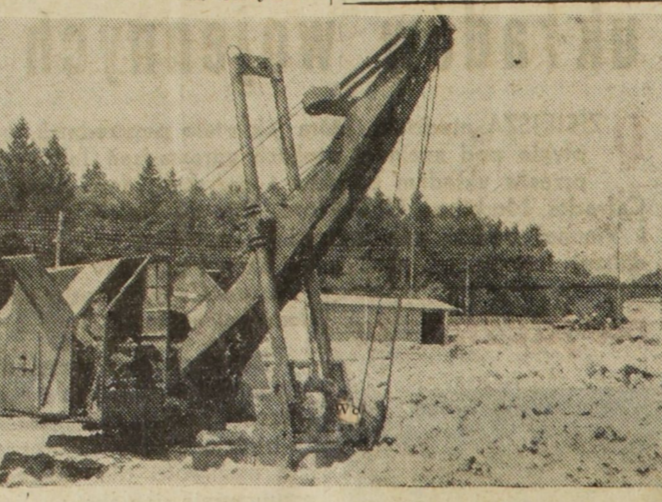
...Pod fundament drugiego bloku wybiera już ziemię nowoczesna koparka.
