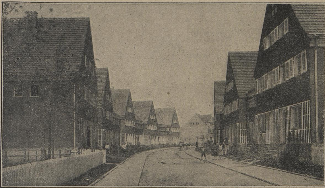
Arbeiterwohnhäuser eines der neuen deutschen Stickstoffwerke (Nach Plänen von Architekt Otto Rudolf Salvisberg, Steglitz.)
