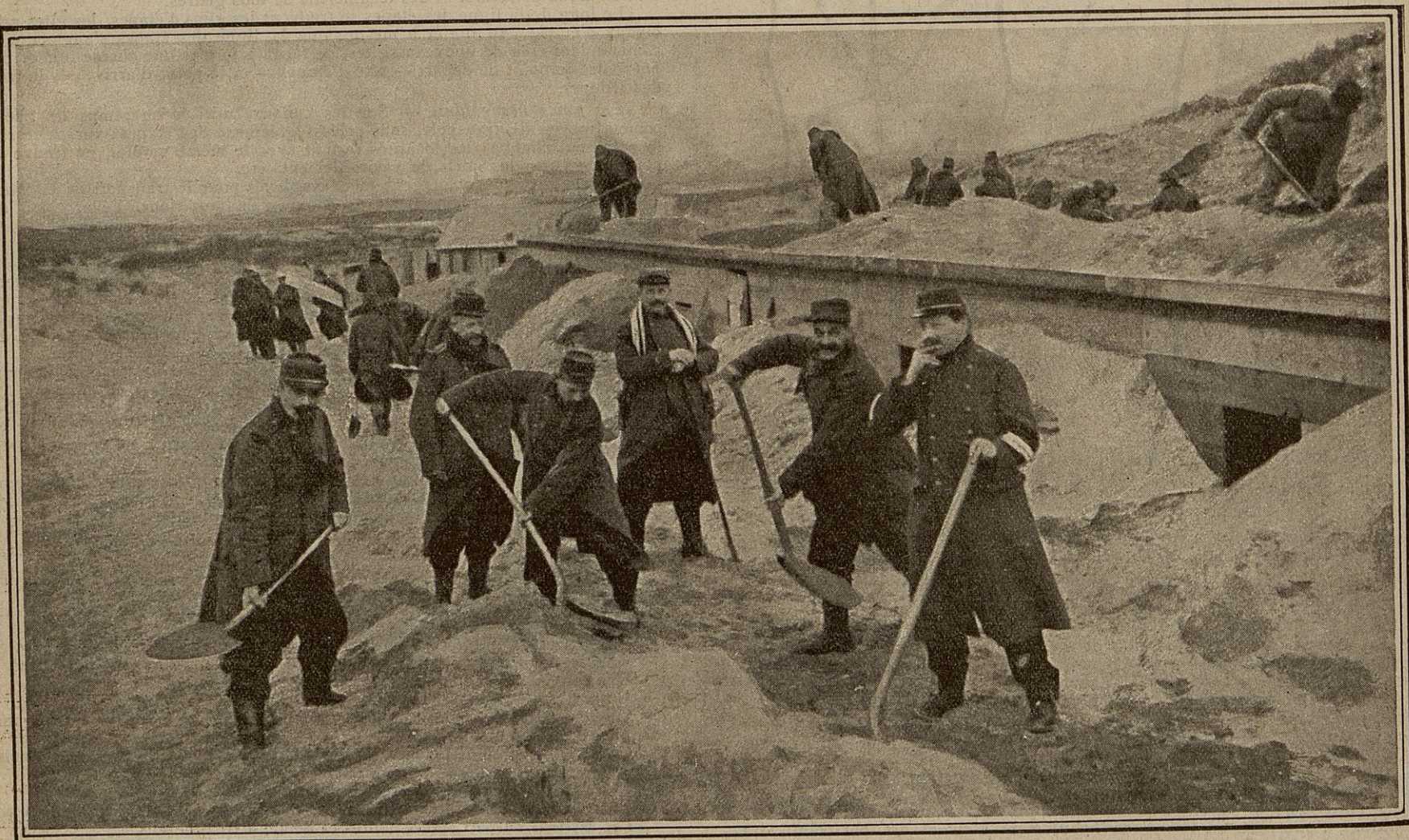
Les abris sont construits au-dessous des grandes dunes de sable qui ondulent les plages de la mer du Nord ; ils sont ensuite complètement recouverts de sable, de façon que les aviateurs ennemis ne puissent les repérer ; on laisse seulement la place des ouvertures entre les monticules de sable ; là-dedans, on pourra braver les « marmites », la pluie et le froid.
