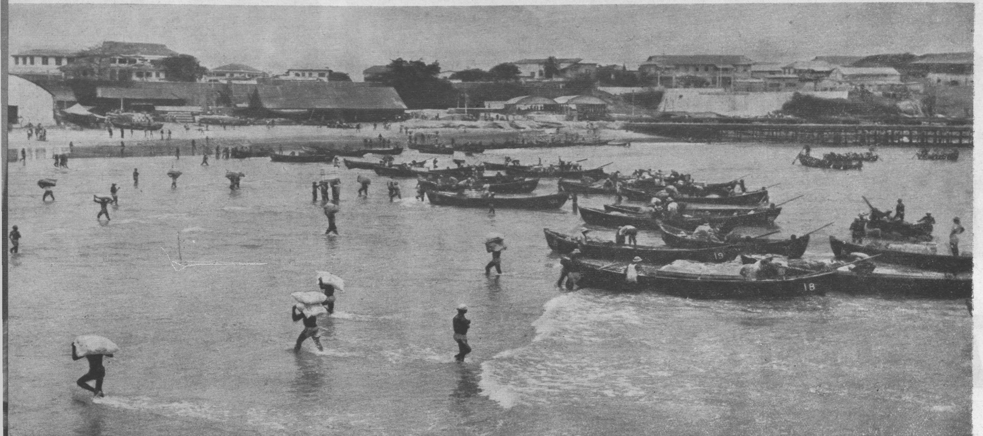
Akakra, gwinejski port, dopiero się szykowała do budowy basenów i nabrzeży. Na takich łodziach przewoźnicy dobijają do statków na morzu i tam je rozładowują
