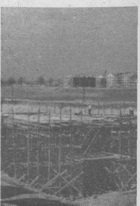
Tym wykopem pojedzie pociąg elektryczny. Górą — wiadukt łączący obie części miasta. Fot. Kubski.
