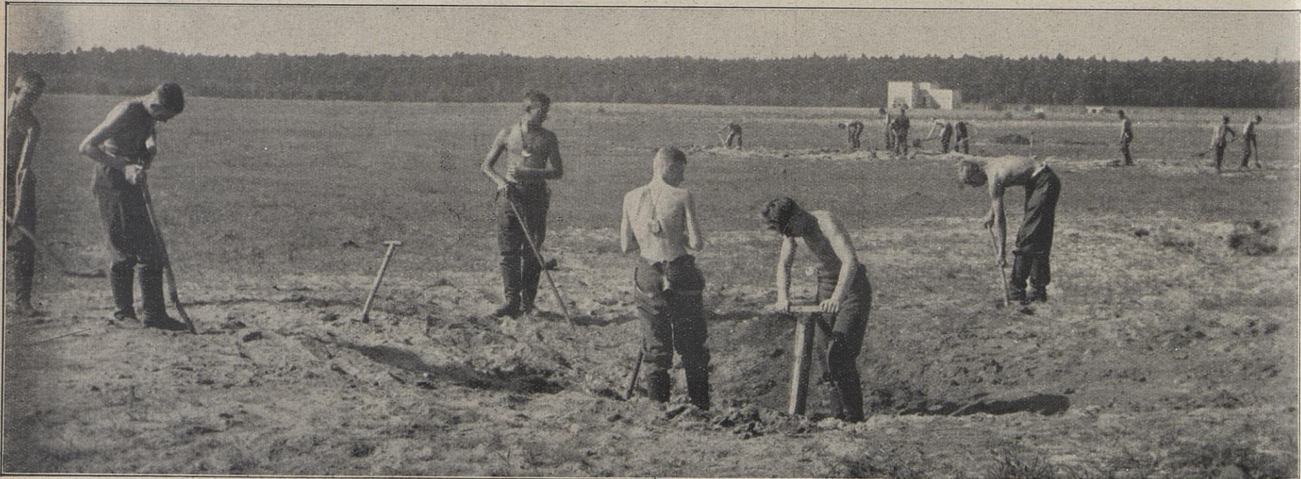
Das polnische Flugfeld war mit deutschen Bomben belegt worden; jetzt ist es deutscher Flughafen geworden. Die Männer des Reichsarbeitsdienstes beginnen ihr Werk... In kürzester Frist sind die tiefen Sprenglöcher ausgefüllt, der Boden festgestampft und eingeebnet. Nun können die deutschen Maschinen von hier wieder zum Feindflug starten.
