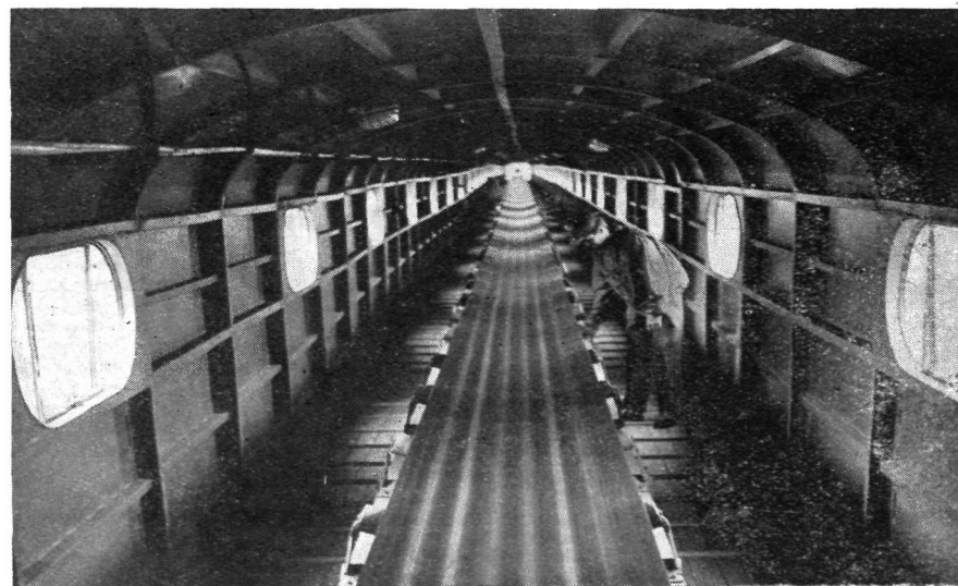
Magazyn z halami fabryki łączy długi tunel, w którym biegnie i taśmociąg
