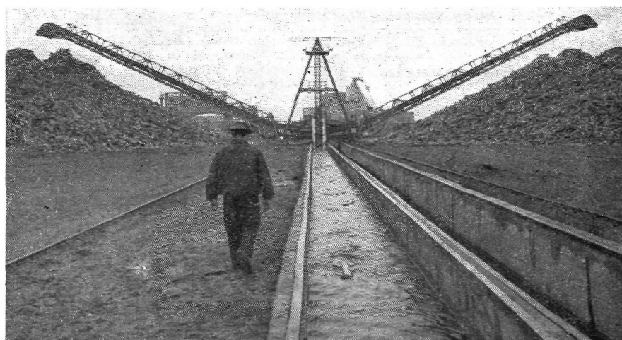
Woda służy i do produkcji i do transportu przenosząc w rynnie bukowe kłocce
