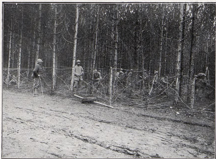
Pose de réseaux de fil de fer à la lisière d'un bois que l'on vient de mettre en état de défense.
