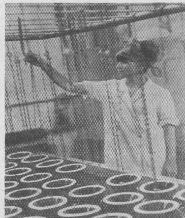
Wytrawny palacz bezbłędnie poznaje czy cykl spiekania odbywa się prawidłowo. Maria Wajda bada zachowanie się izolatorów pod napięciem
