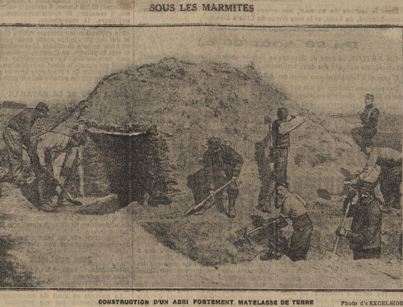
CONSTRUCTION D'UN ATRI FORTEMENT MATELASSÉ DE TERRE
