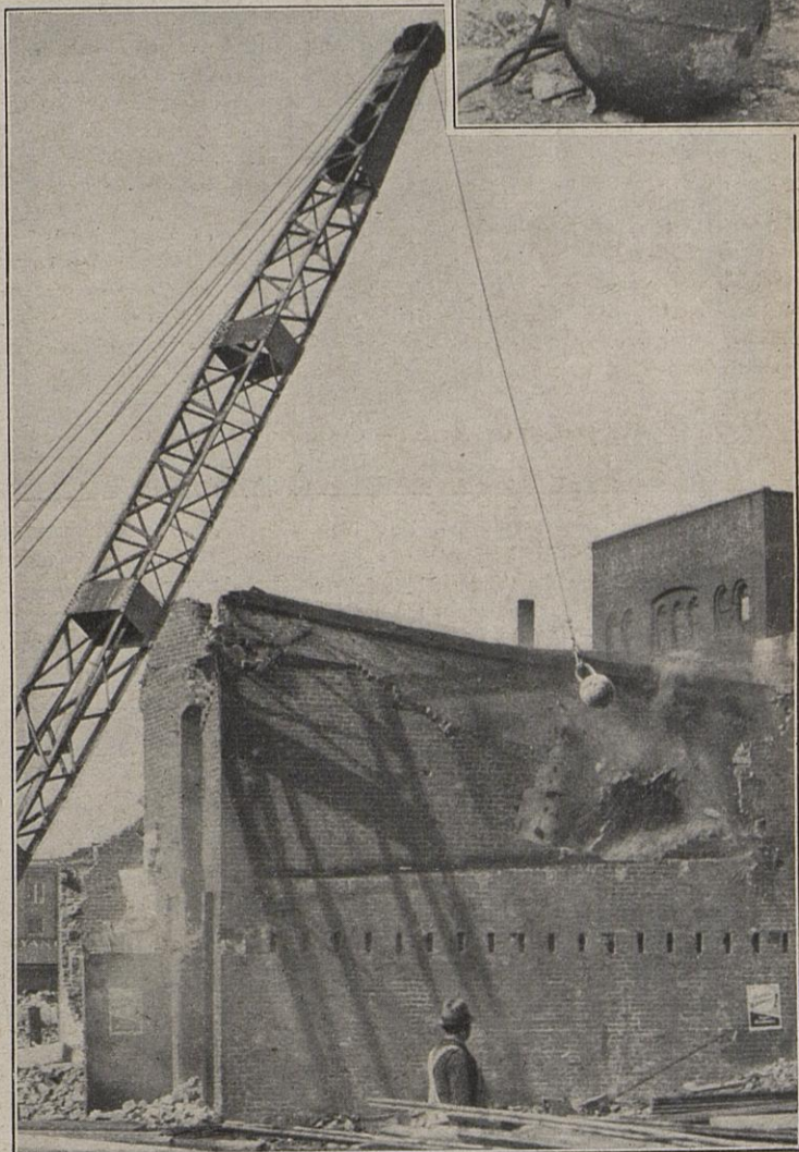
Ein eiserner Ball schwingt durch die Luft, kracht an die Mauer, und berstend bricht sie auseinander.
