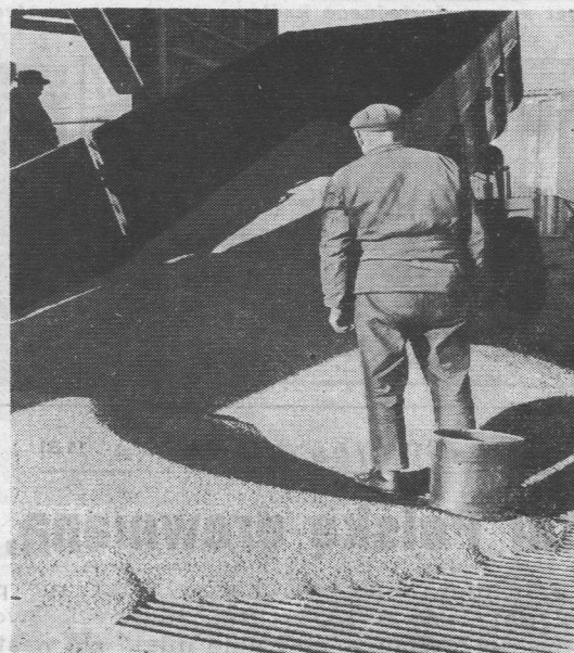
Silos może przyjąć i oczyścić w ciągu jednej godziny 50 ton zboża. Pierwsza faza — to wysyp zboża przez kratę przyjęciową. Poniżej: zbiorniki na oczyszczone i osuszone zboże
