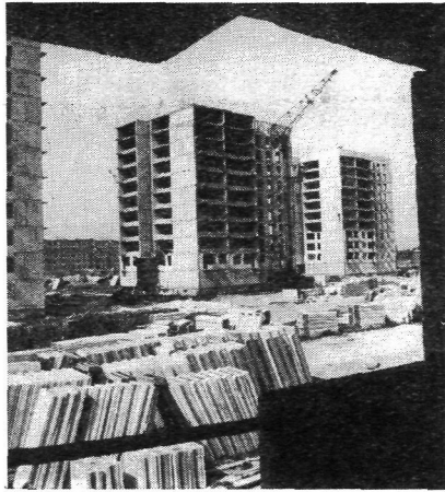
WARSZAWA 1968 — WARSZAWA PRZEMYSŁU. Odbudowa stolicy dawno już zakończona, teraz mówimy o rozbudowie i ulepszeniu miasta. Rozbudowa zaś w szybkim tempie wymaga uprzemysłowienia budownictwa, tak zwanych metod wielkopłytowych. Na Bródnie buduje się osiedle na 20 000 osób
