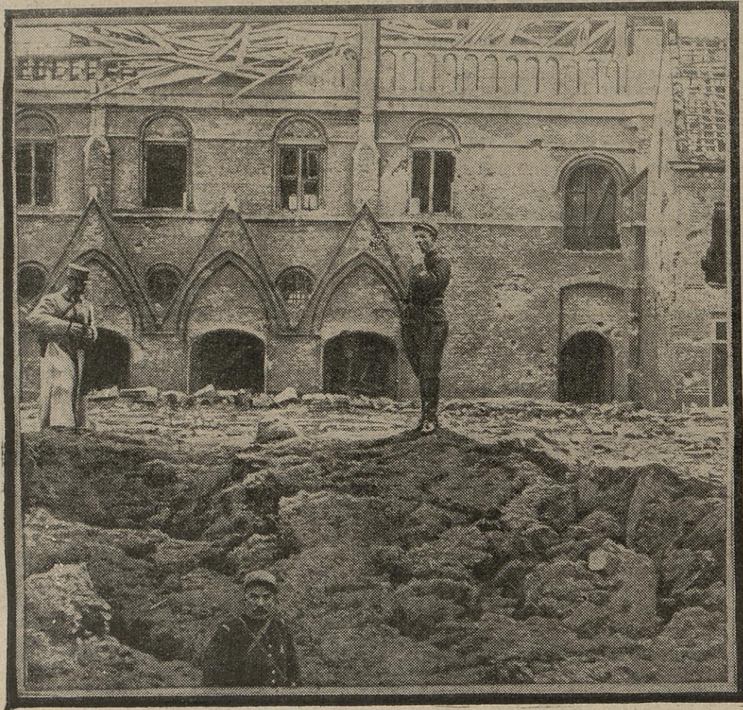
Nieuport, en Belgique, n'est pas ménagée par l'artillerie ennemie. Récemment encore, une grosse pièce de 420 laissait tomber sur la ville un gros obus qui, en explosant, fit devant les halles une immense excavation.
