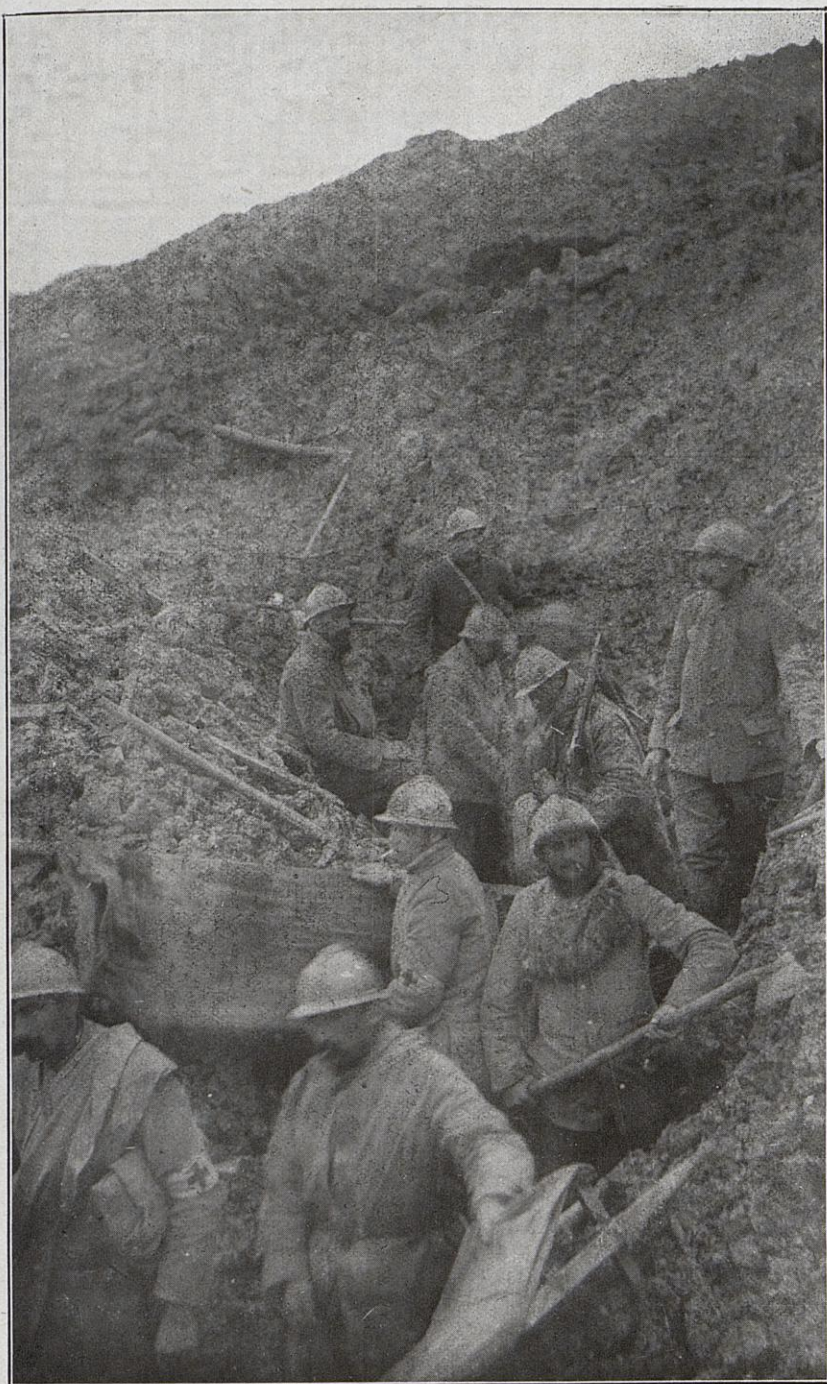
LES ABORDS DE LA REDOUTE 320, ENTRE VAUX ET DOUAUMONT. — Ils ont été à un tel point bouleversés par le feu de notre artillerie, que nos troupes du génie ont dû creuser un puits pour retrouver l'entrée de l'ouvrage.
