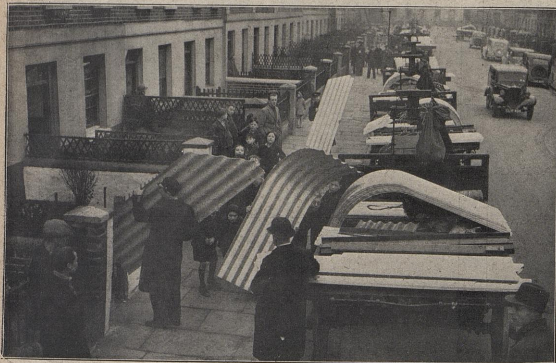
Seltam geformte Stahlblech-Platten wandern in die Häuser... Aus ihnen baut man Luftschutzhäume. In London und in 22 großen Städten verteilt die amtliche Luftschutzstelle diese Stahlblechplatten an die Häuser, die Gärten besitzen. Die ersten Auslieferungen begannen in London.
