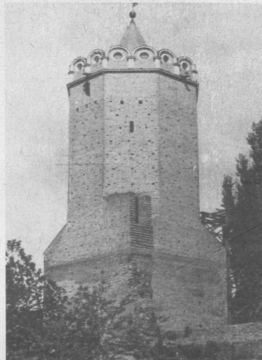
Niegdyś wspaniały zamek z czasów Kazimierza Wielkiego, który „został Polskę drewnianą, a został murywaną”, stanowi jedną z najcenniejszych zabytkowych budowli w Łęczycy (woj. łódzkie). Od kilku lat zamek poddawany jest pracom konserwatorskim. Ostatnio zrekonstruowano jego wspaniałą wieżę, tak charakterystyczną dla swojej epoki.
