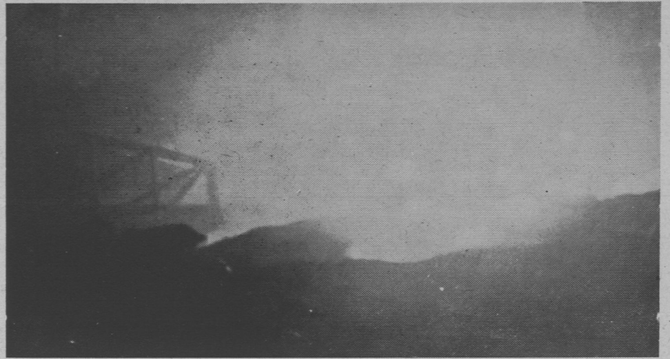
Wysadzenie mostu na rzece Wisłoka w nocy z 5/6 kwietnia b.r.
