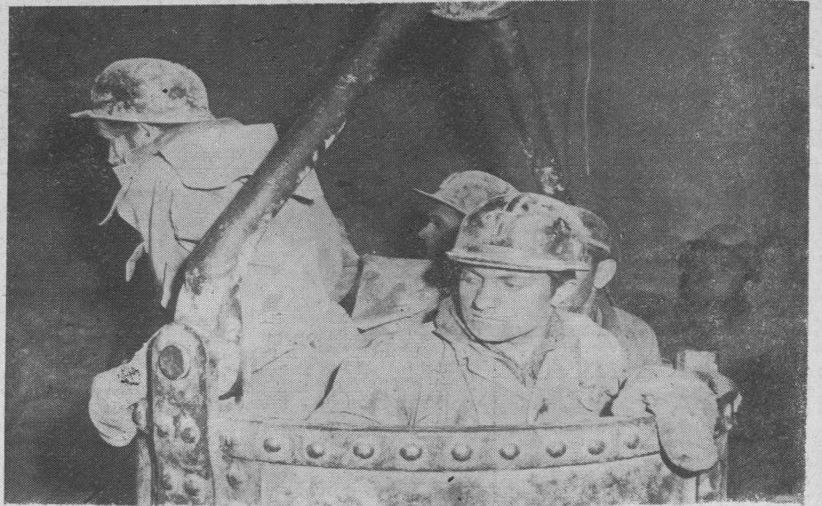
En creusant un nouveau puit de mine par la méthode de „réfrigération” les spécialistes de Mysłowice ont atteint 65,5 m. par mois, ce qui est un record
