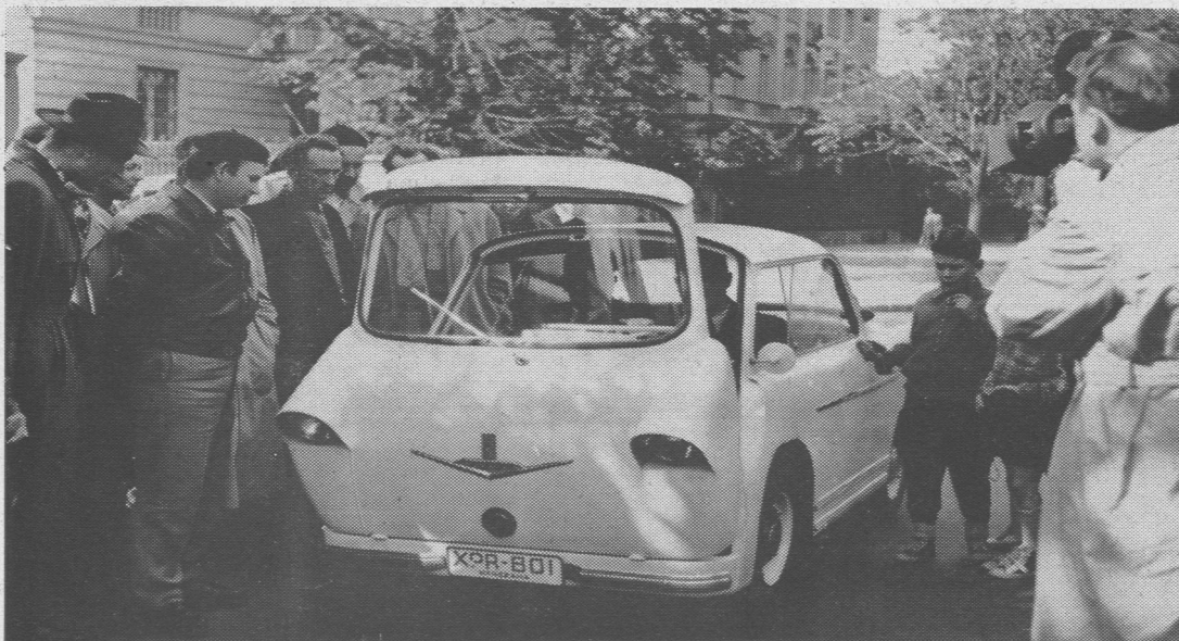
A oto „Smyk”: przód otwierany, można wysiadać. Prototyp nowego polskiego mikrosamochodu, produkcji Warsztatów Centralnego Biura Konstrukcyjnego Przemysłu Motoryzacyjnego w W-wie.
