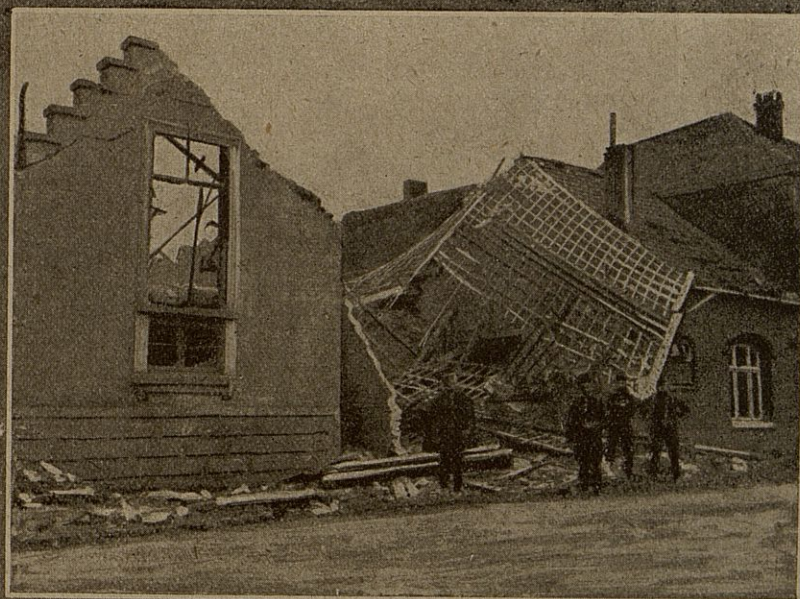
Les charpentes des toitures ont pris des positions inclinées qui menacent grandement la vie des passants. Il faut se garer de ces charpentes branlantes que le moindre vent emporte.
