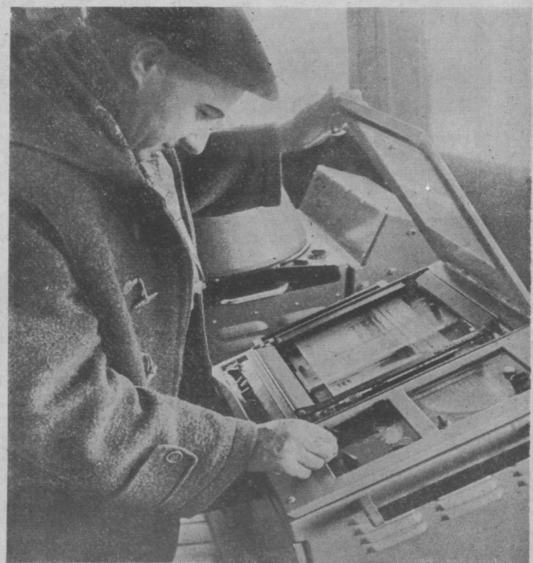
Dzięki temu aparatowi wykrywa się obecność ryb w odległości półtora km przed statkiem (szerokość kąta obserwacji 45°). Drugi aparat bada morze przy pomocy fal poddźwiękowych na głębokość
