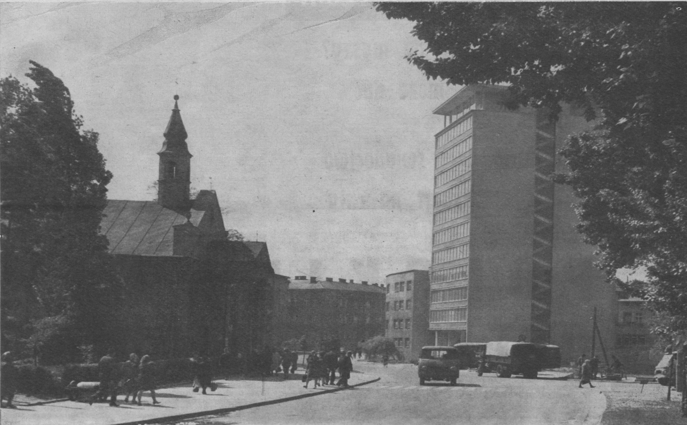
Przy wąskich uliczkach, obok starych kamienic wyrastają w Rzeszowie nowe, piękne wieżowce, budynki mieszkalne
