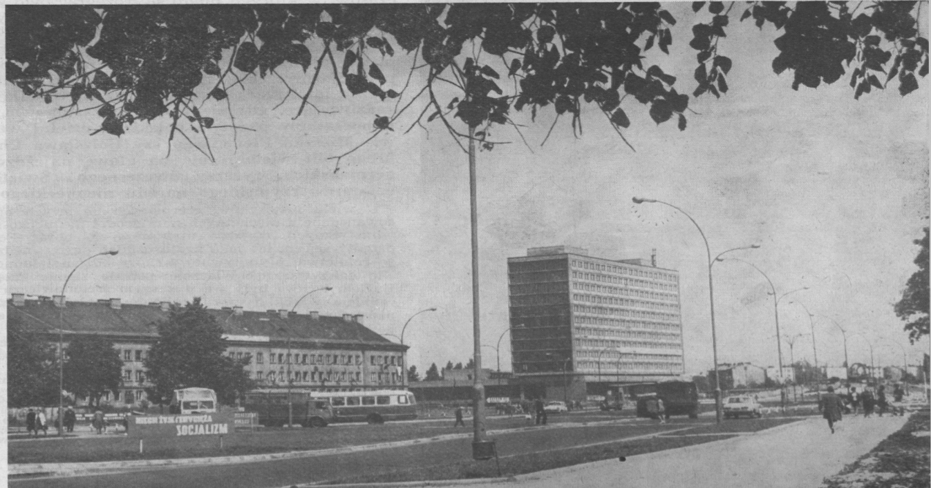
Budujący się ogromny hotel jest symbolem przemian Rzeszowa. Tu zamieszkają liczni turyści
