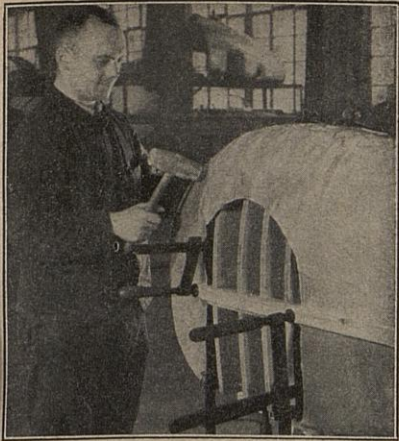
Radverkleidung nach Maß. Die Stromlinienverkleidung wird aus Leichtmetall-Blech um ein Holzmodell des Rennwagens kalt herausgehämmert.
