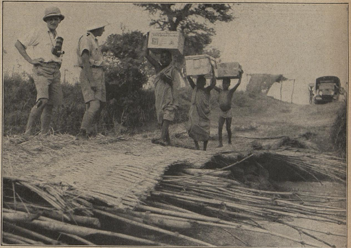
Die Wagen schaukeln im Zwanzig-Kilometer-Tempo dahin. Da — eine Behelfsbrücke aus Bambus und Matten über einem ausgetrockneten Flußarm. Die schwersten Kisten werden erst hinübergetragen, damit der Wagen nicht durchbricht. Fot. Kurt Neubert (2)
