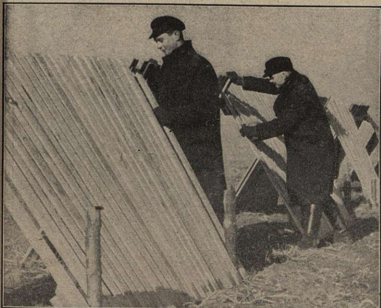
Lattengestelle, die den Wind abfangen, wurden gegen plötzlich auftretende Luftströmungen zum Schutze der Rennwagen neben der Rekordstrecke aufgestellt. Schirner (1), Weltbild (1)
