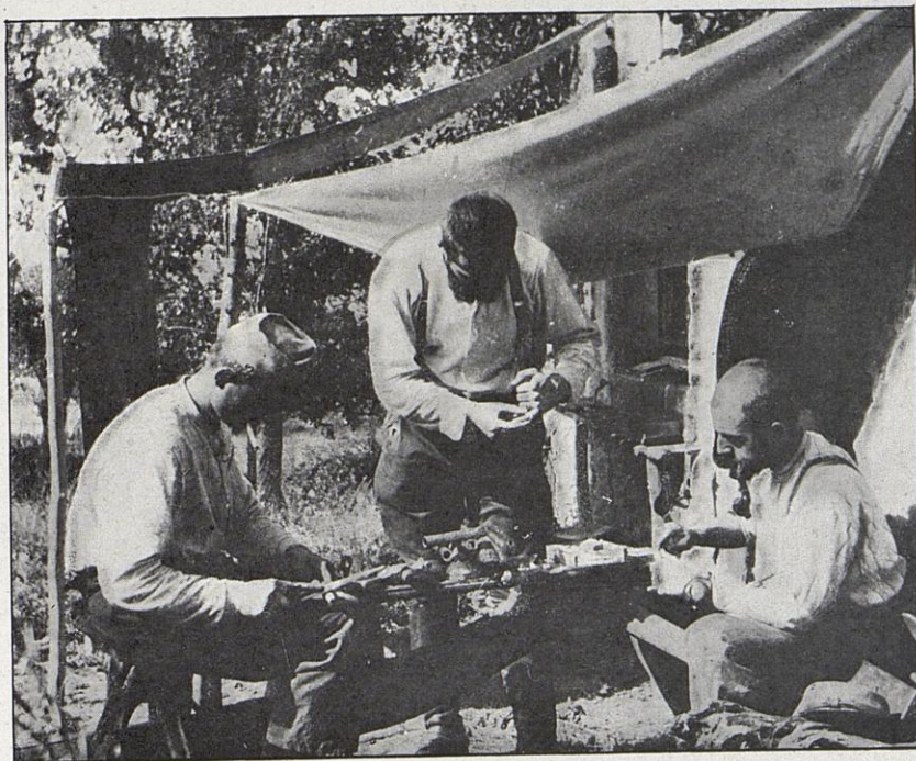
V. — La rondelle est dégrossie, limée, ciselée, polie, à l'aide d'un outillage fort primitif, imaginé de toutes pièces par les joailliers de la tranchée. Et la bague sera bientôt digne d'orner le doigt d'une Française.
