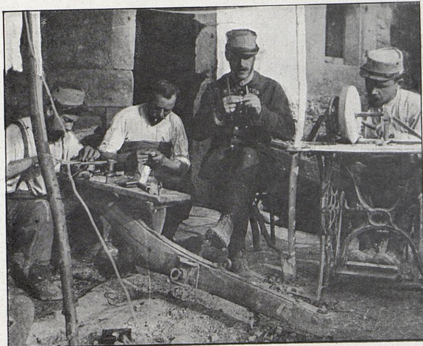
VI. — Certains de ces consciencieux artistes enchâssent dans le chaton un fragment de vitrail ramassé dans les ruines d'une église, et qu'ils mettent à la forme voulue à l'aide d'une meule installée sur une vieille machine à coudre.
