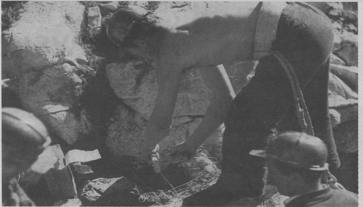
Luźne bloki skalne zagrażają katastrofą. Zostaną strącone wybuchami górniczych ładunków dynamitu
