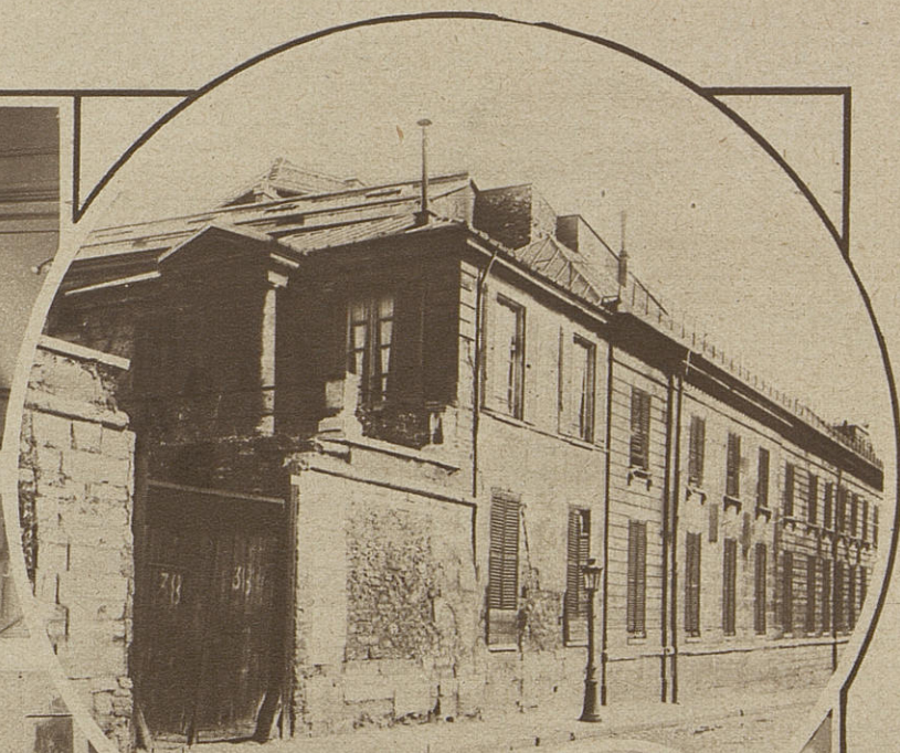
Façade de l'orangerie aux portes vermoulues
