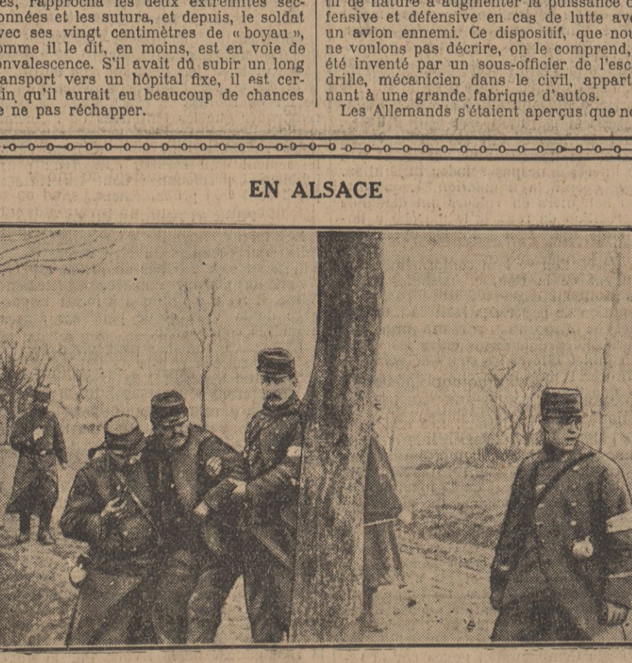
SOLDAT BLESSE CONDUIT A L'ARRIERE
