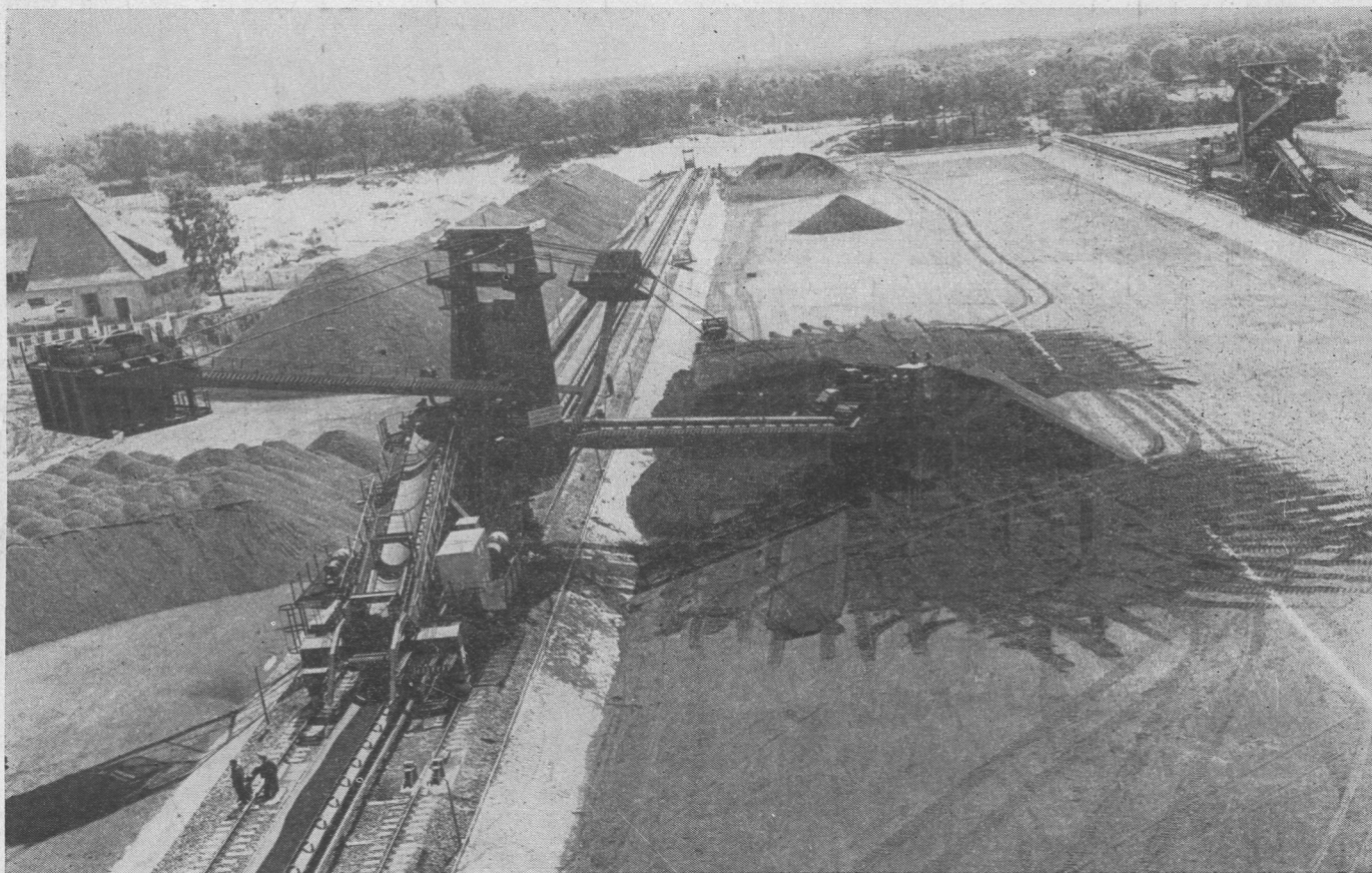
Port w Swinoujściu zbudowano kosztem 230 mln złotych i wyposażono w nowoczesne urządzenia przemysłowe
