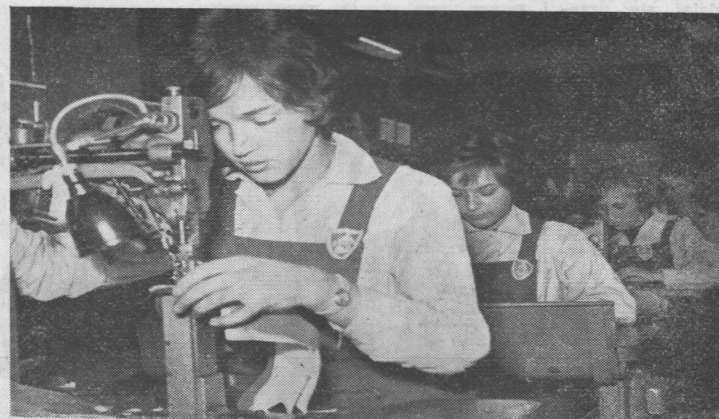
Technikum oraz Zasadnicza Szkoła Przemysłu Skórzanego w Radomiu posiadają bardzo dobrze wyposażone warsztaty. Jest tu 550 najnowocześniejszych maszyn. Korzysta z nich 1.300 uczniów oraz wielu robotników „Radoskóru”, którzy tu podwyższają swoje kwalifikacje. Widzimy zszywanie cholewek
