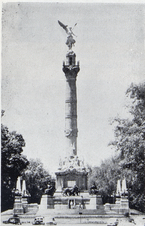
Colonne de l'Indépendance à Mexico (architecte Rivas Mercado)
