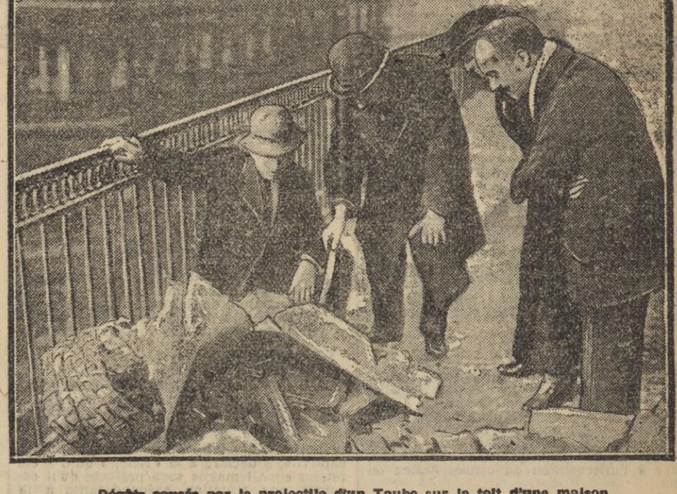
Dégâts causés par le projectile d'un Taube sur le toit d'une maison située rue de la Banque, à Paris. Photo BRANGEL.
