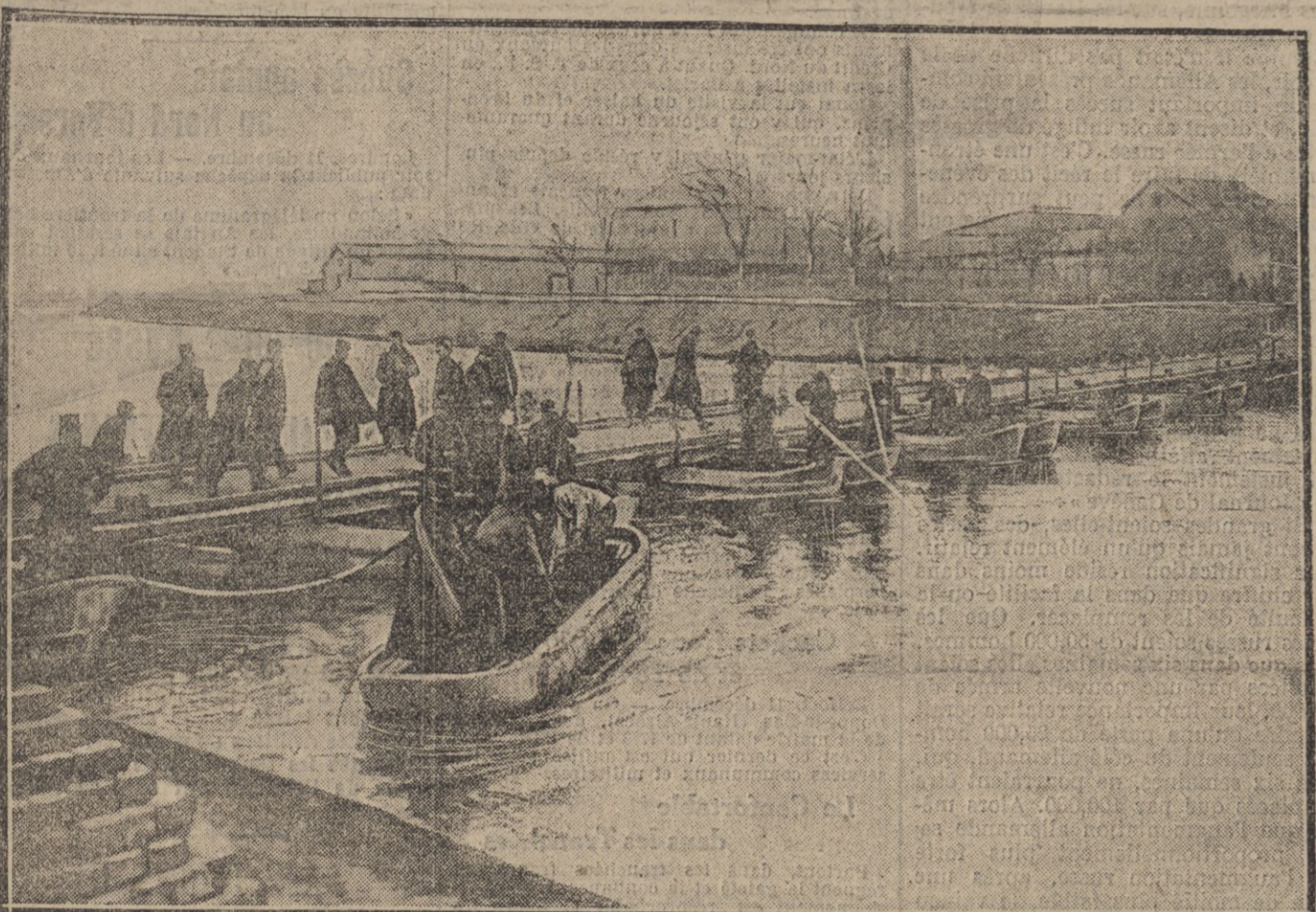
RETABLISSEMENT D'UN PASSAGE SUR LE CANAL DE VERBERIS (Oise) Photo ROL.
