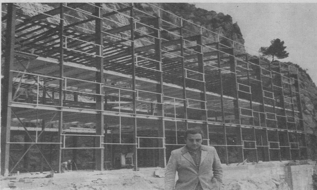
W malowniczej miejscowości Roquebrune Cap Martin, w dep. Alpes-Maritimes wznoszą hotel na 60 pokoi z wielopiętrowym garażem i wielu innymi wymogami, które dyktują projektantom współczesna turystyka i hotelarstwo
