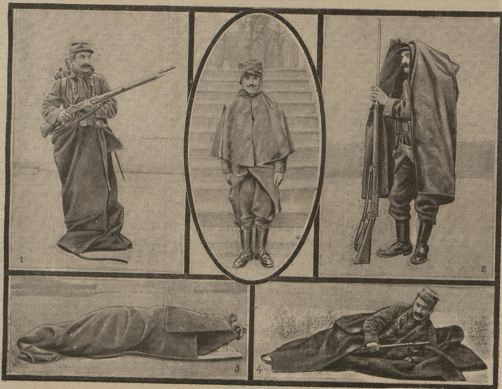
1. — Le « Bivouac individuel » met complètement à l'abri de l'humidité les pieds, les jambes et le ventre du soldat obligé de séjourner dans les tranchées. 2. — Il sert au soldat, debout et spécialement en faction, sous la pluie, d'abri qu'importe. 3. — Le soldat se dispose à bivouaquer et met avec lui, à l'abri de l'hu-
