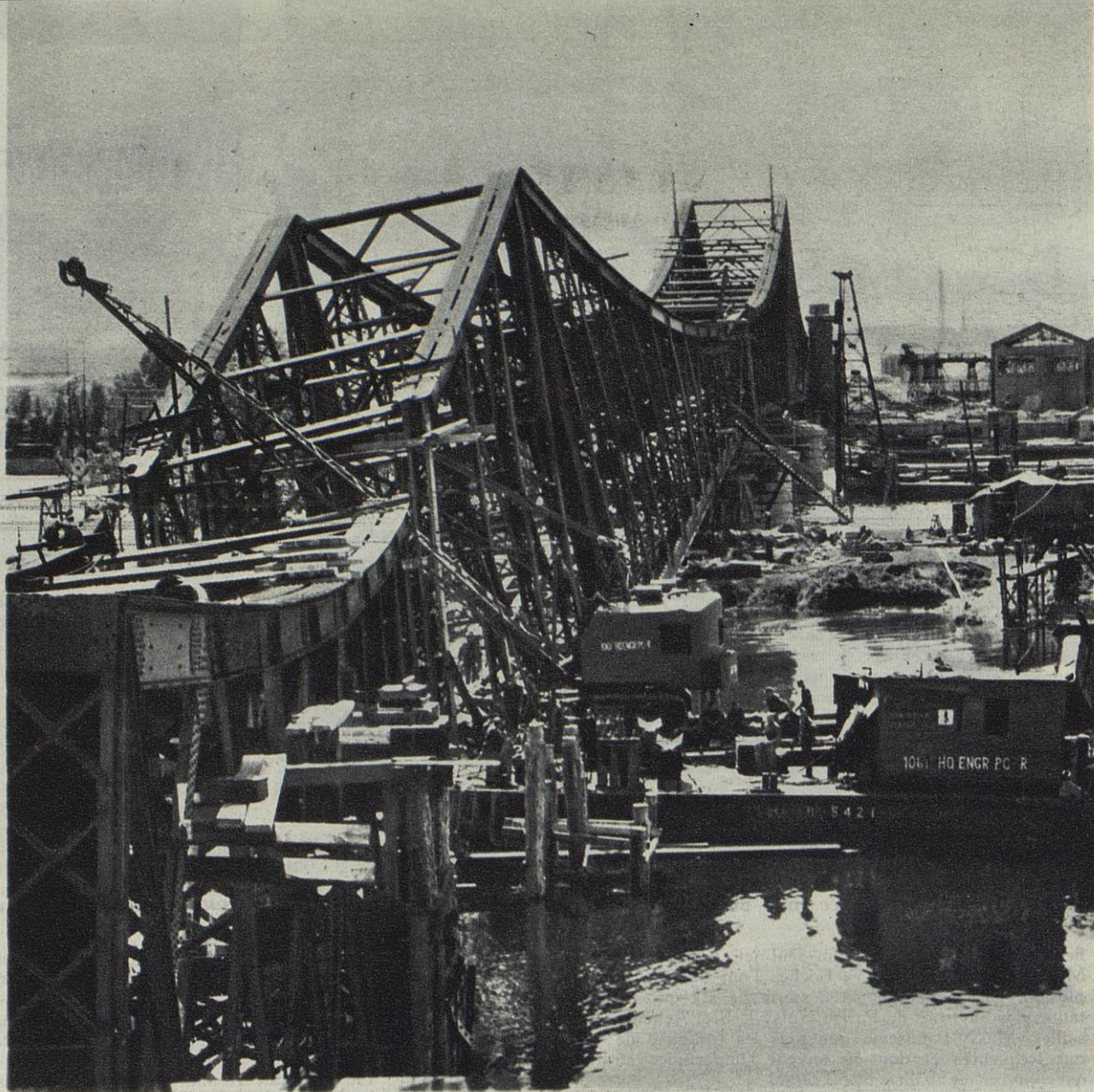
LE PONT DU VAL D'EAUPLLET, PRES DE ROUEN, IL Y A UN AN. 1.800 TONNES D'ACIER S'ETAIENT, EFFONDREES DANS LA SEINE.
