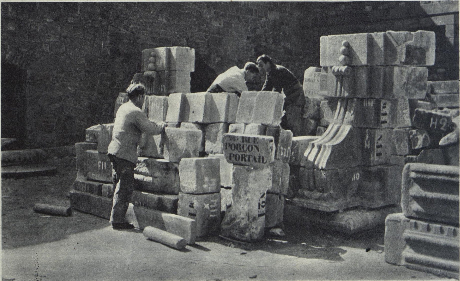
CHAQUE PIERRE EST BROSSEE, NETTOYEE ET CLASSEE AVEC SOIN. LES TRAVAUX SONT PLACES SOUS LA SURVEILLANCE DE M. CORNON, ARCHITECTE EN CHEF DES MONUMENTS HISTORIQUES.
