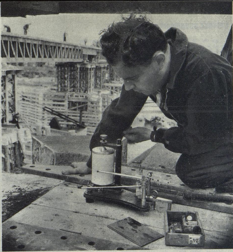
UN INGENIEUR, INCLINE SUR LES APPAREILS, VERIFIE LES OSCILLATIONS DU NOUVEAU PONT.
