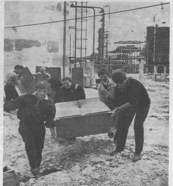
Ochotnicza praca społeczna harcerzy Mazowsza na terenie płockiej Petrobudowy pozwoliła im zapoznać się z wieloma problemami tego wielkiego kombinatu i jego zadaniami
