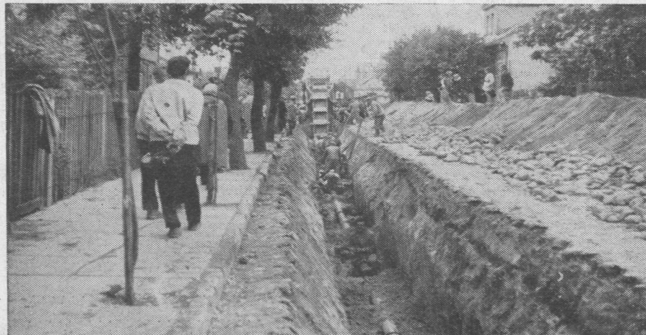
Do Przasnysza zawiata nowoczesna koparka — 110 m. na godzinę kopie rowy do rur kanalizacyjnych. Nareszcie będzie kanalizacja.
