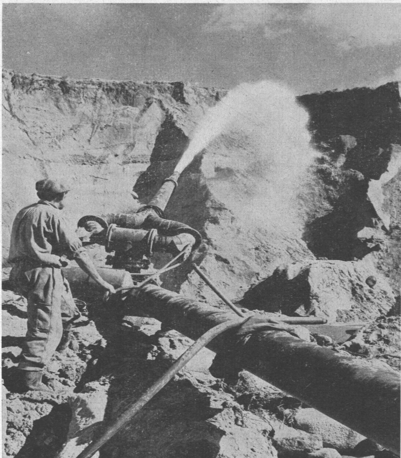
Strumień wody rozkopuje ziemię na zbiornik... wodny.
