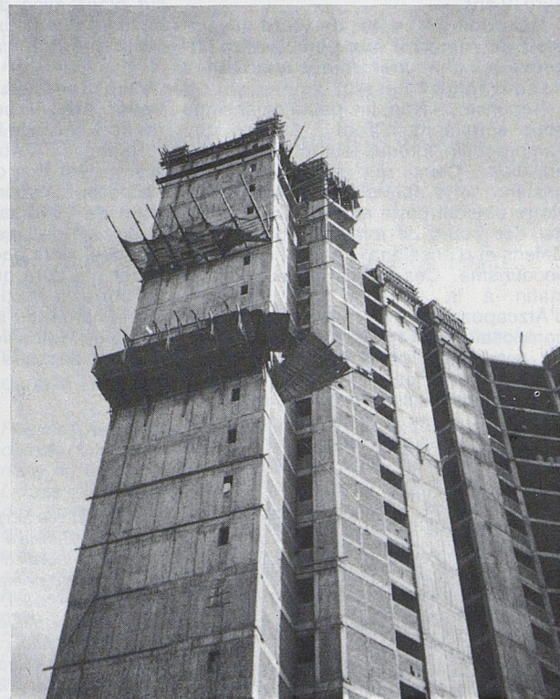
Un grand ensemble multi-familial en construction dans le nord de la ville
