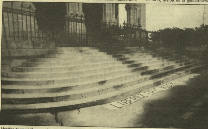
Marches du Sacré-Cœur repeintes, gratuitement par des amis d'Eric (photo C.S.R.).
