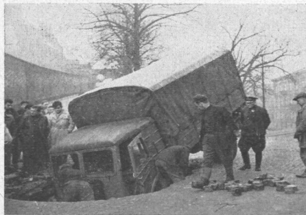
W Krakowie samochód zapadł się pod ziemię — jezdnię podmyły stare wodociągi.
