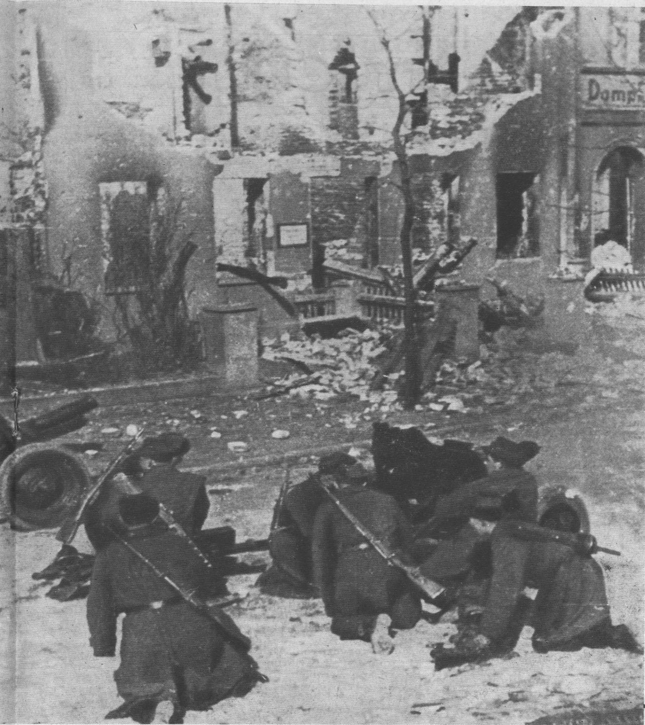
rdzę miała liczne umocnienia, bunkry i wzmocnione stanowiska ogniowe. Walki toczyły się tutaj o każdy dom
