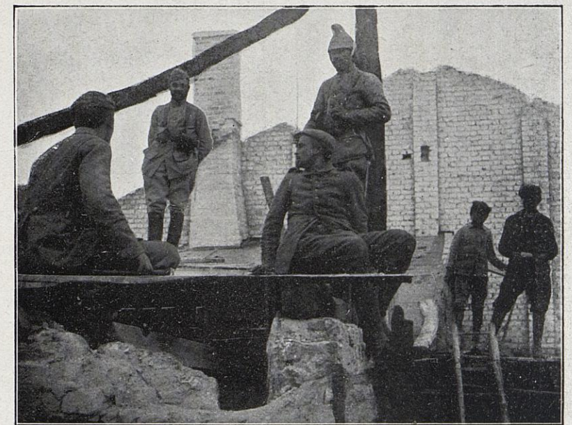
Prisonniers allemands occupés à réparer les dégâts du bombardement.
