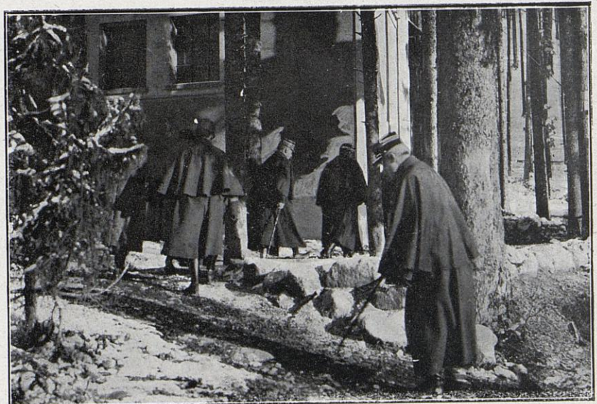
Après l'inspection des premières lignes en Alsace, les généraux rentrent déjeuner au siège du commandement.
