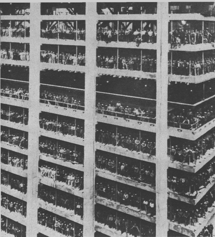
Po zakończeniu budowy kolosalnego gmachu nowojorskiego banku wszyscy zatrudnieni na budowie robotnicy stanęli w oknach i w taki sposób powstało wyjątkowo ciekawe, imponujące zdjęcie
