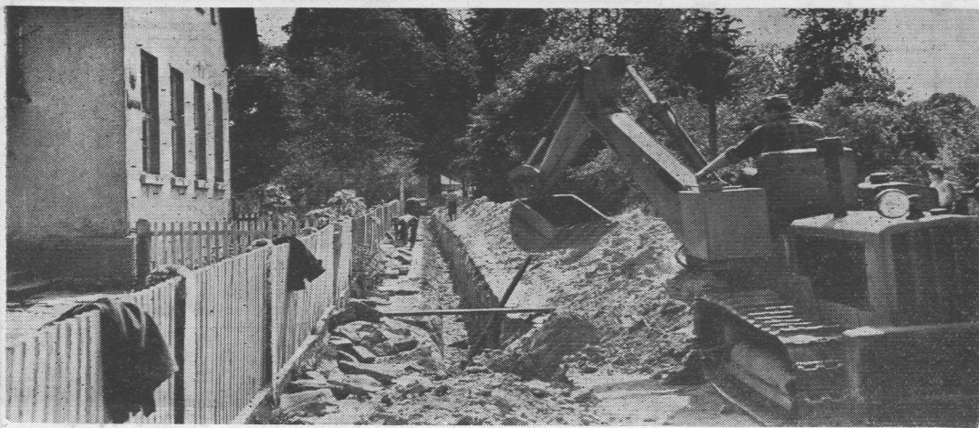
Mosty, dans la voïvodie de Szczecin, seront un des nombreux villages à disposer bientôt d'un réseau rural d'adduction d'eau. Une grande partie des travaux de terrassement nécessaires est accomplie par les villageois.
