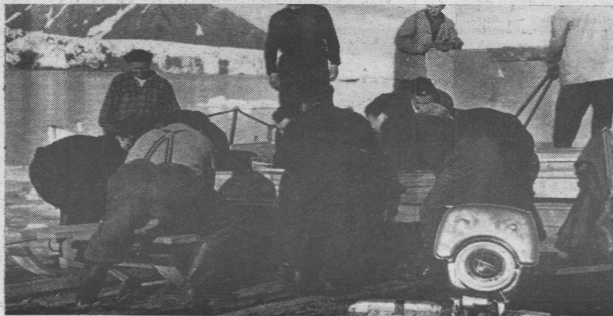
Część składanego domku przenosimy z tratwy na specjalne sanie.
